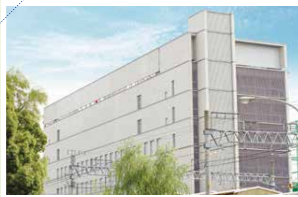
JR東海大曽根ビル(愛知県)／施工:2006年／設計:JR東海コンサルタンツ
