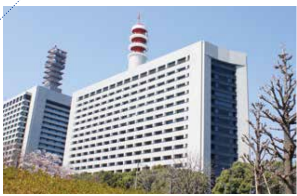
警視庁本部庁舎(26)外壁改修工事(東京都)／施工:2017年
