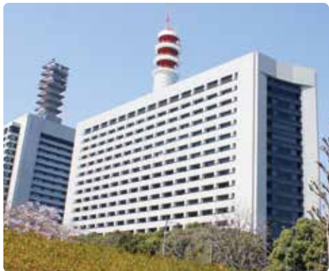
警視庁本部庁舎(26) 外壁改修工事(東京都) 施工:2017年
